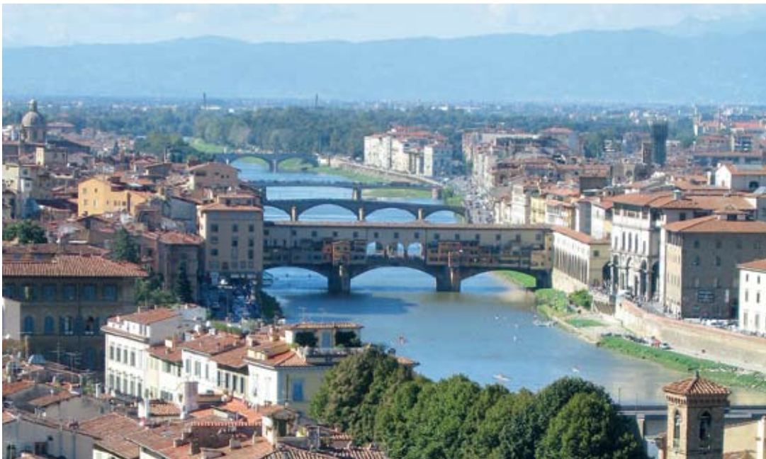
Ponte Vecchio, Florence
